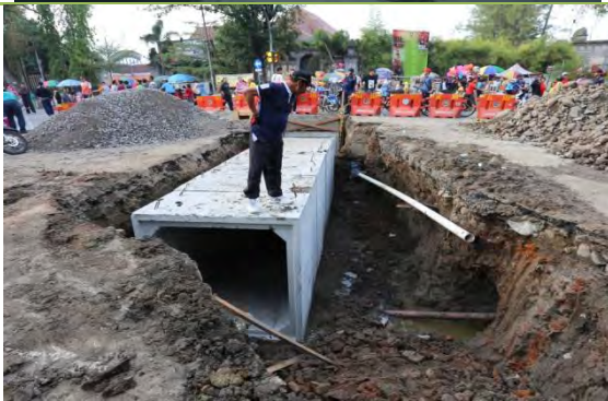
Gambar 4.23 Proses pemasangan Box culvert di Kota Surakarta
