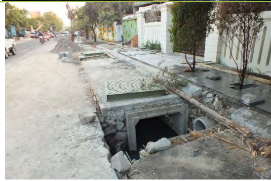
Gambar 4.23 Proses pemasangan Box culvert di Kota Surakarta
